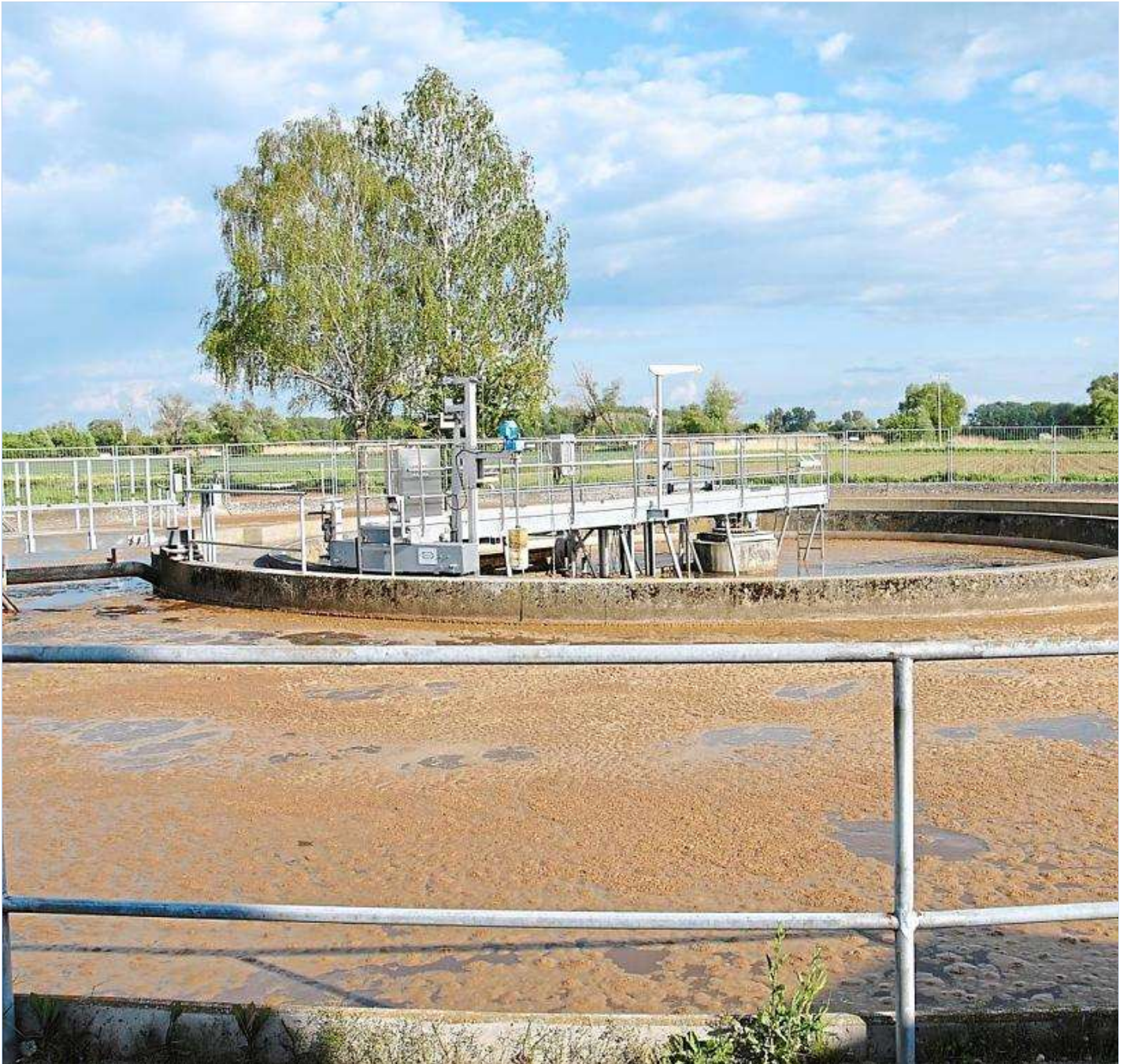
Wird mit einem Kostenaufwand von etwa drei Millionen Euro saniert: die Kläranlage der Gemeinde Buxheim; links die alte Anlage, rechts die neue. | Foto: Heimbüchler
